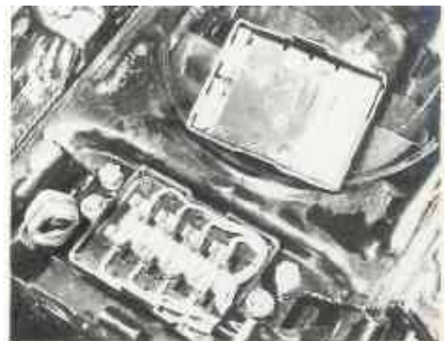
Bild 334 Der Sicherungskasten des Modells K5000C sitzt über der Batterie
